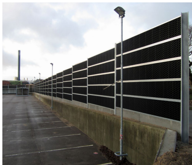
Lydabsorberende side af støjskærm mod Tican Industries
